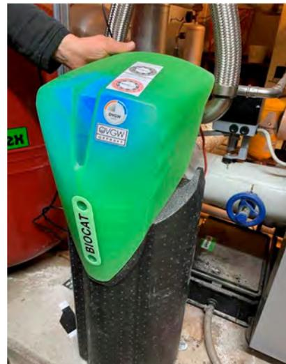
Ohne eine Wasseraufbereitungsanlage lagert sich Kalk in Leitungen, Armaturen und Pumpen ab. Durch den Einbau einer Wasseraufbereitungsanlage werden Kalkablagerungen verhindert bzw. gestoppt. Auf Grund dessen werden wir dieses Jahr eine Wasseraufbereitungsanlage in der Wohnanlage Altöttingerstraße einbauen.
