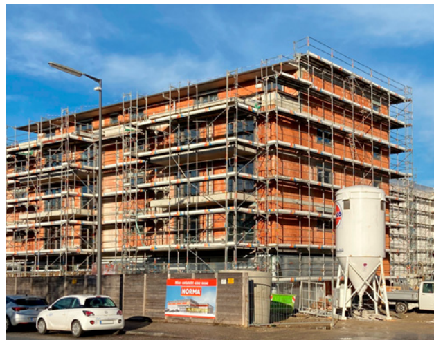
Hier entsteht im EG der zukünftige NORMA
