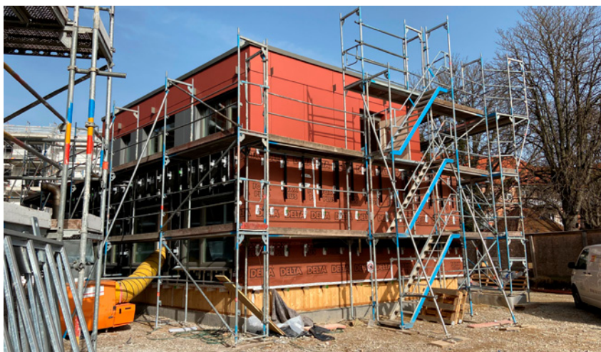
Die Kita mit Außenbeplankung
