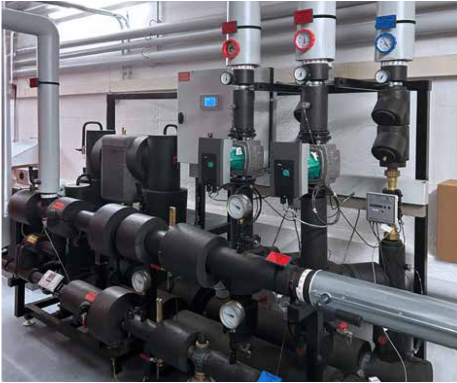
Ein Beispiel für eine Fernwärmeübergabestation (links).
