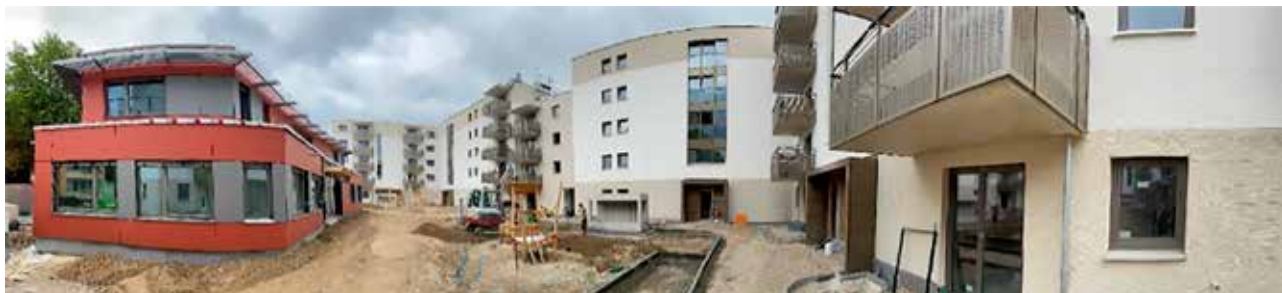
Bauteilbegehung Freienfelsstraße/Wiesentfeller Straße in Neuaubing
