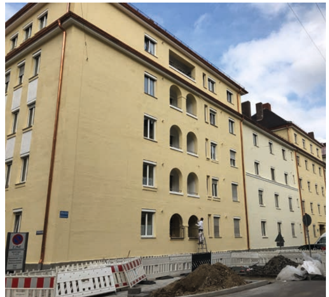
Fassade im September 2020
