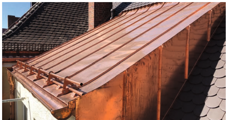
Dachanschluss im September 2020
