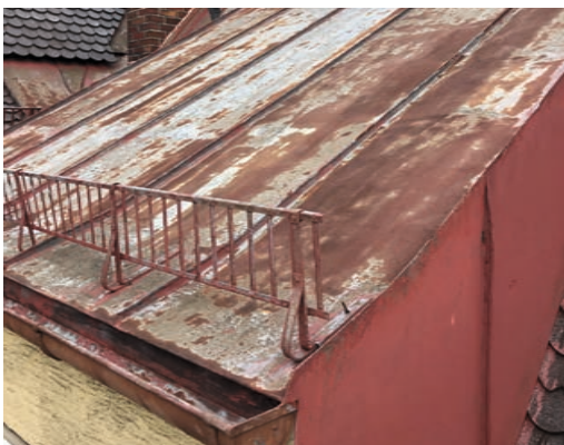
Dachanschluss im Mai 2020
