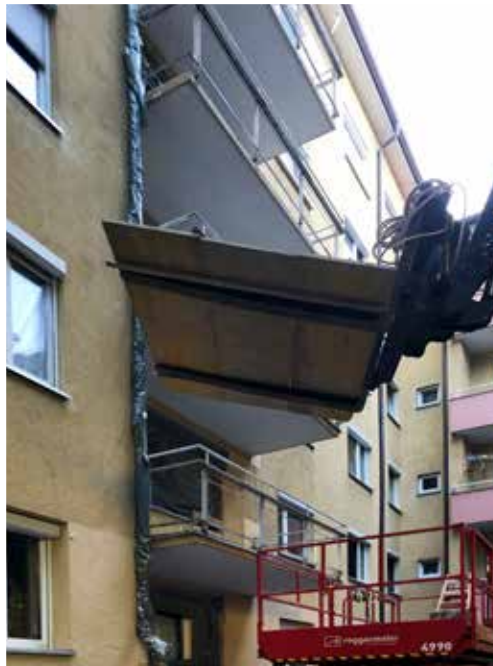
Die vorhandenen Balkone wurden abgetrennt und werden durch eine vorgesetzte Anlage ersetzt.
