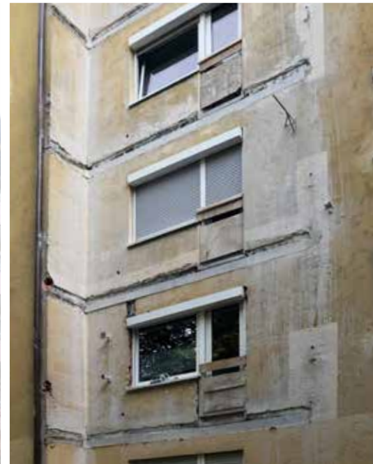
Die vorhandenen Balkone wurden abgetrennt und werden durch eine vorgesetzte Anlage ersetzt.
