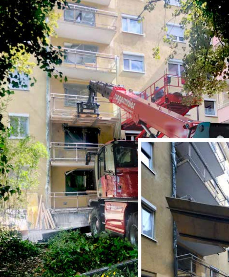
Die vorhandenen Balkone wurden abgetrennt und werden durch eine vorgesetzte Anlage ersetzt.
