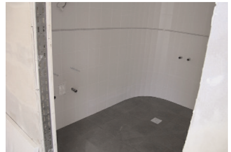
Vorbereitungen für ein behindertengerechtes Bad
